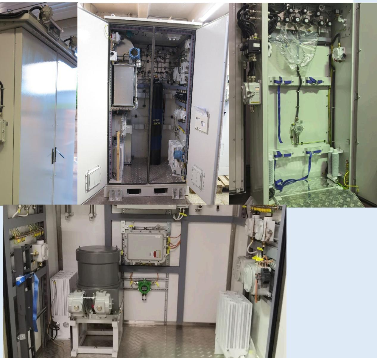
**Оборудование систем охранно-пожарной сигнализации и установки пожаротушения** предназначены для обеспечения безопасности работы персонала и оборудования, его сохранности и своевременного обнаружения пожароопасных ситуаций. В установках и шкафах производства ООО «Технодизайн-М» по техническому заданию и проектной документации заказчика может устанавливаться оборудование любых современных производителей охранно-пожарной сигнализации и установок пожаротушения.
